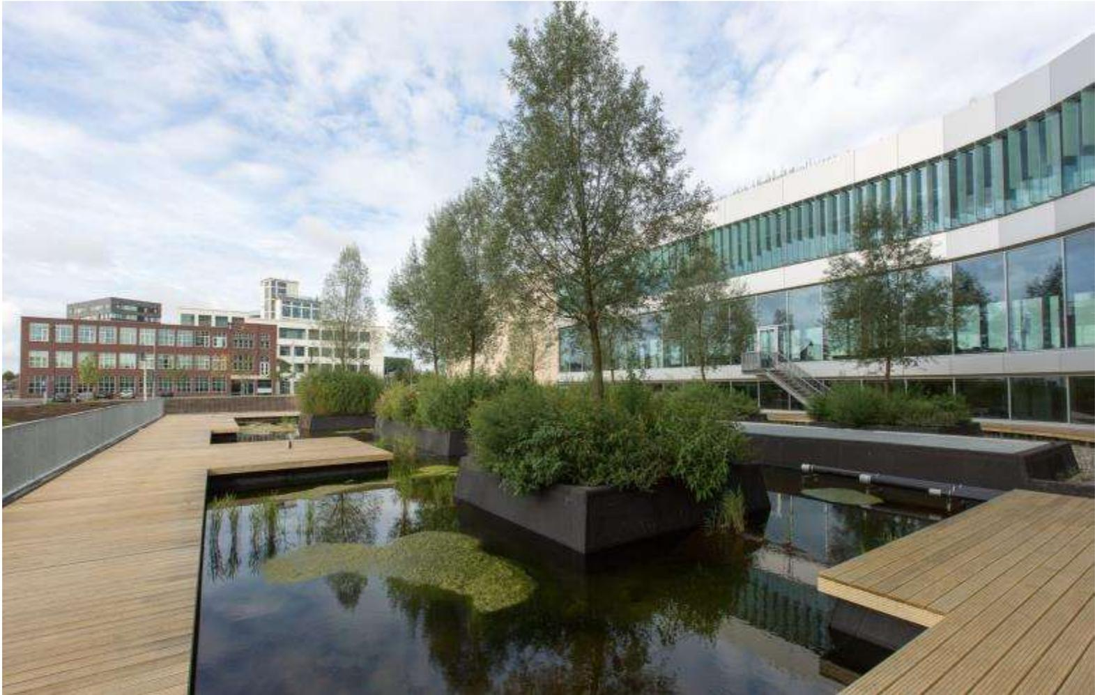
Das Regenwasser wird aufgefangen und zur Bewässerung der grünen Fassade verwendet. Die Wasserströme werden demnächst noch stärker getrennt.
